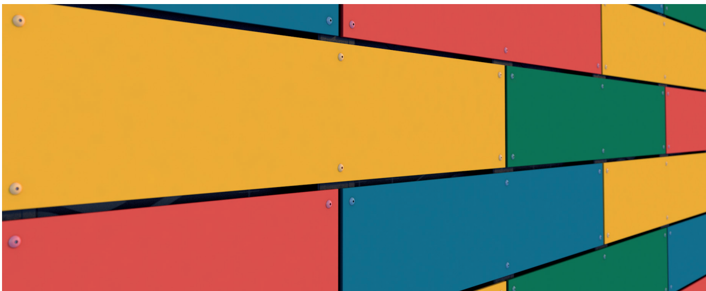
Панели из ламината высокого давления (HPL-панели) крепятся цветными фасадными шурупами соответствующего цвета.
